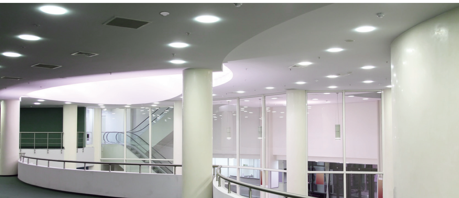
Indoor vochtbestendige armaturen – Ondergrondse parkeergarage met
