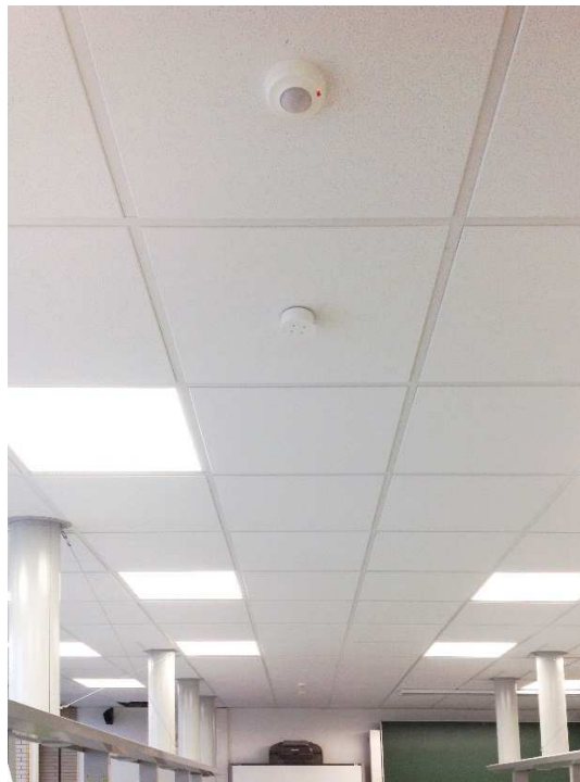
Deckenmelder PD2-KNX im Klassenraum / PD2-KNX-Aufputz an der Decke
