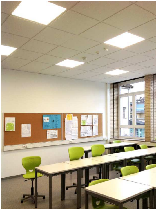
Deckenmelder PD2-KNX im Klassenraum / PD2-KNX-Aufputz an der Decke
