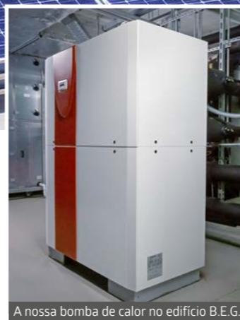
A nossa bomba de calor no edifício B.E.G.
